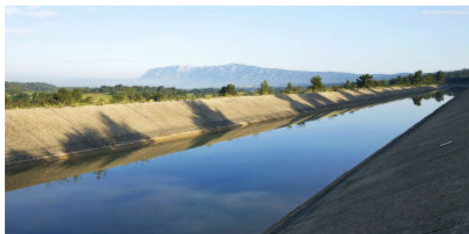
Le Canal de Provence à proximité de la Montagne Ste-Victoire (© SCP)
